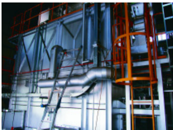
消化槽を加温するため新たに導入された木質バイオボイラ
