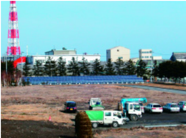
広い敷地内の一角に設置された太陽光発電パネル。最大50kWを発電する
