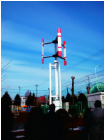
電力の供給先である小学校にも風力発電設備を設置している
